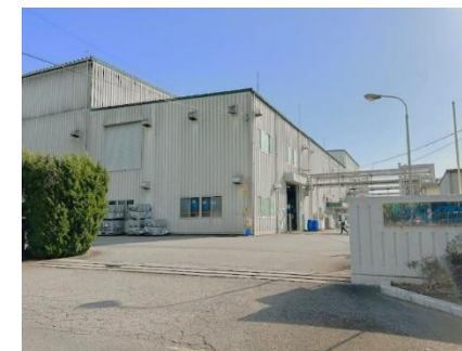
遮熱施工 つくば工場の屋根の一部に施工し 夏場の高温状態を緩和
